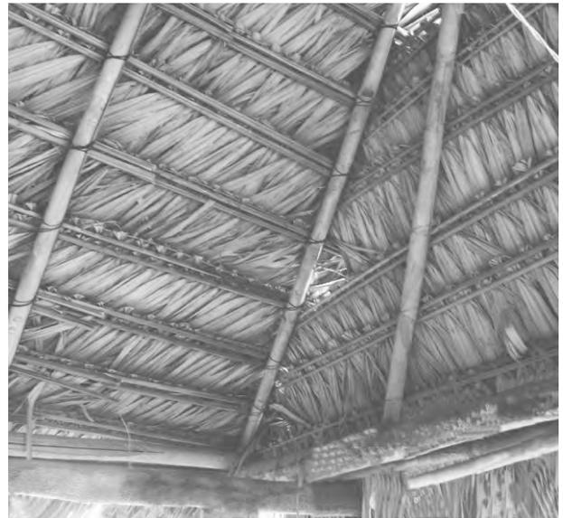
Figura 3: Estructura interior del techo de una edificación y revestidas con hojas de palma.
