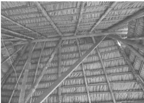
Figura 2: Estructura del techo tradicional.
